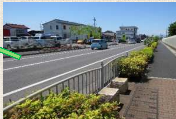
(図2-30) 安堀町美茂呂町線 駅北工区(H23)
